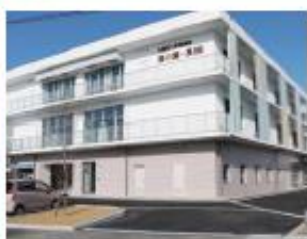
医療法人晴生会 介護老人保健施設 葵の園・長岡 長岡市新保町 【電話】0258-24-1100(開放準備室) ・入所:100名(ユニット型個室40床) ・通所:30名
